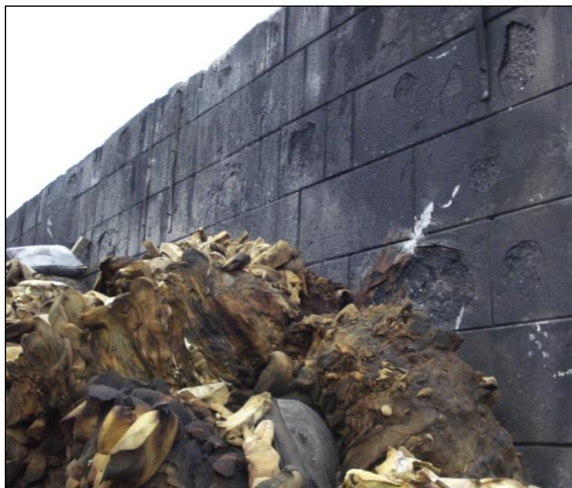
Abbildung 4: Schäden durch Abplatzen
