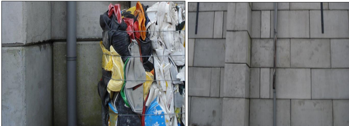
Afbeelding 2: aansluitingen Legioblocks keerwand met naden en vellingkanten
